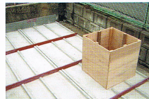
▼点検口設置状況
