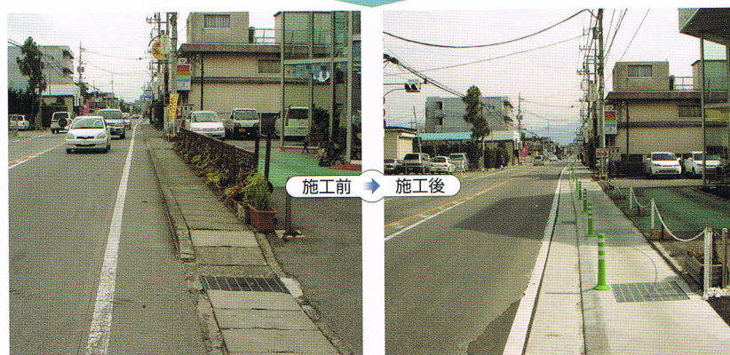
側溝蓋周辺歩道部も改修した例
