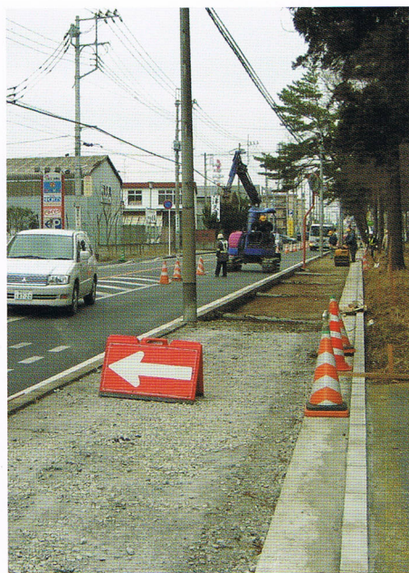
▲KCフォーム施工
